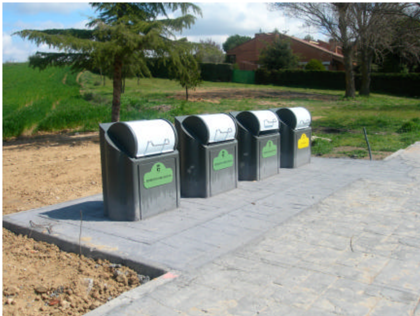
Instalación del sistema de contenedores soterrados en el municipio de Valdeolmos-Alalpardo
